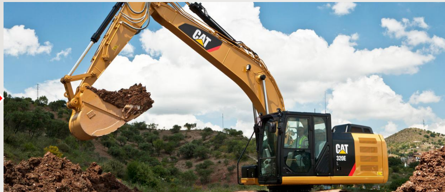
機械（重機）で掘る
