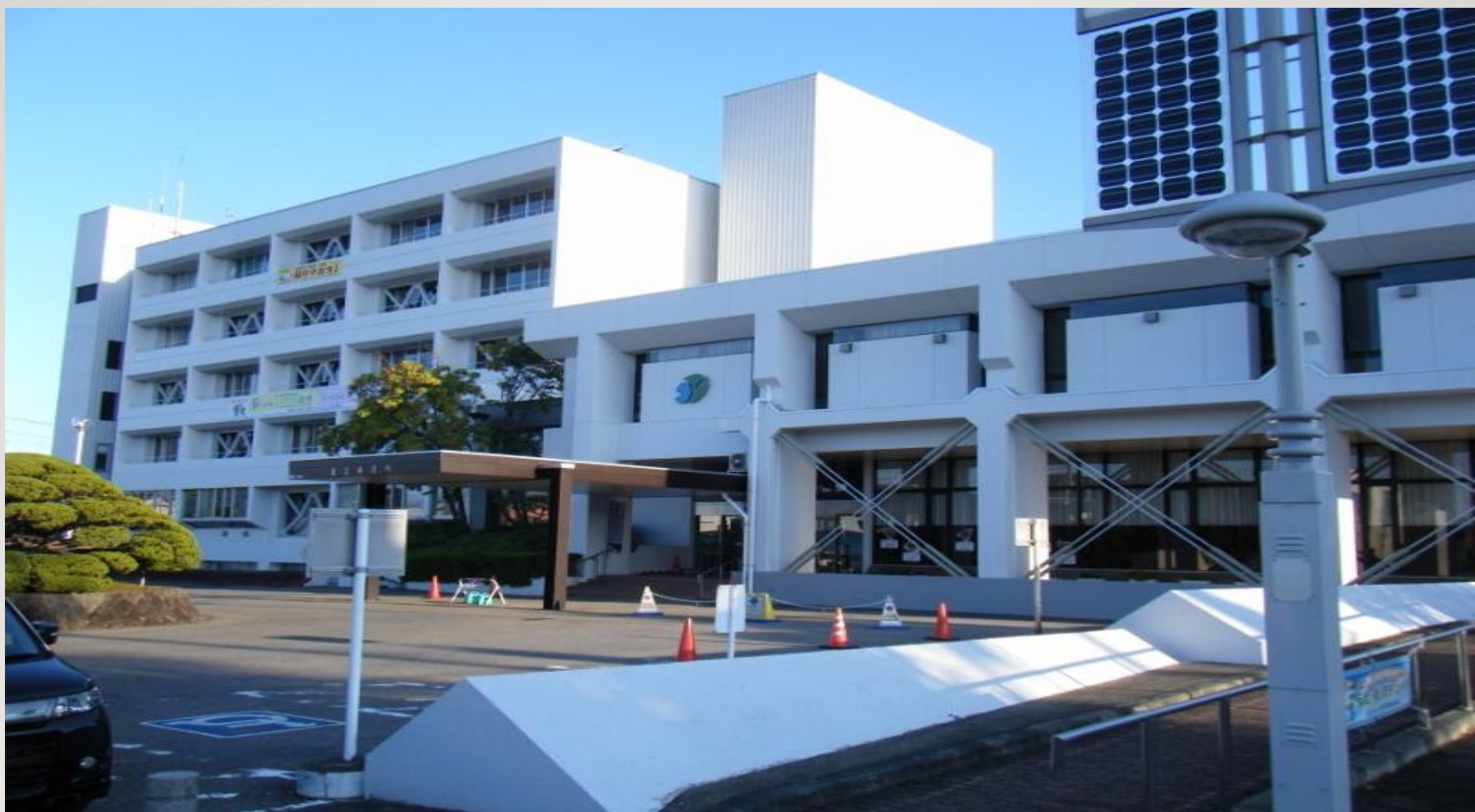
北上市役所本庁舎（耐震改修）
